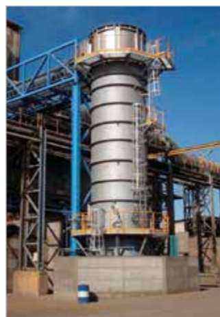
高温急冷HTQ技术，用于快速废气冷却和减少二恶英排放
